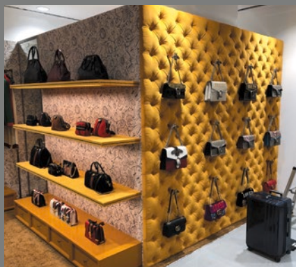
デコレーション壁面ふとん張り
